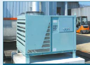
工場の建屋横への設置状況
